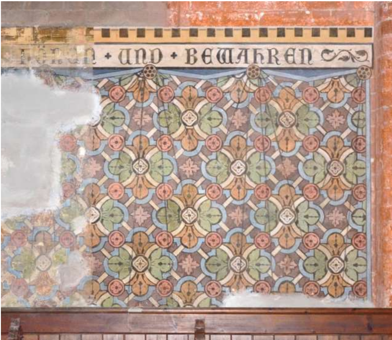
Foto 40 Links Vorzustand – rechts Vorhangmalerei nach dem Retuschieren
