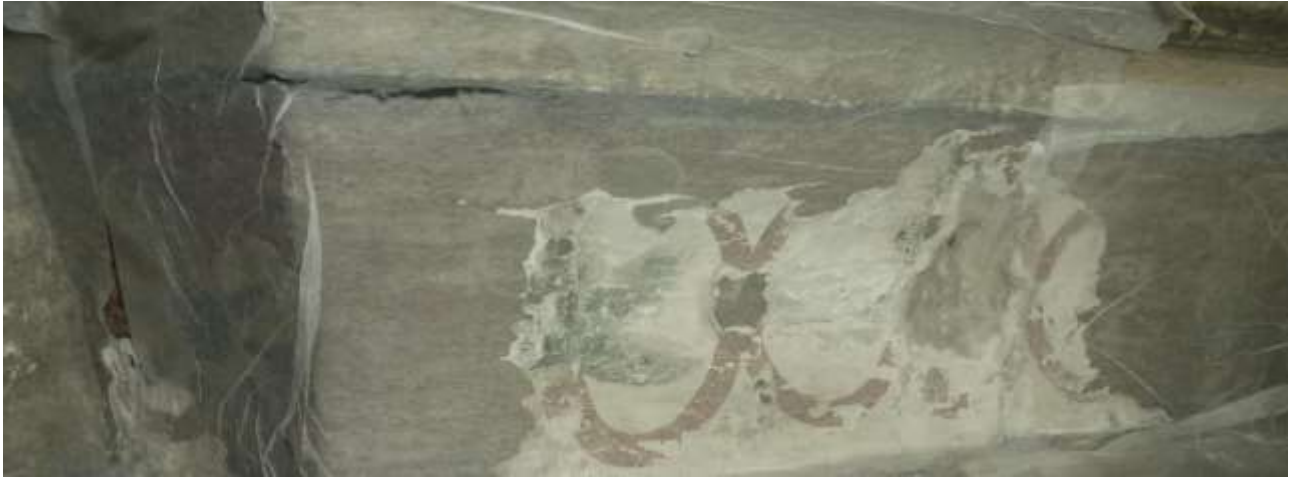
Foto 42 Japanpapierüberklebung der Erstfassung auf dem Kapitell einer Stütze
