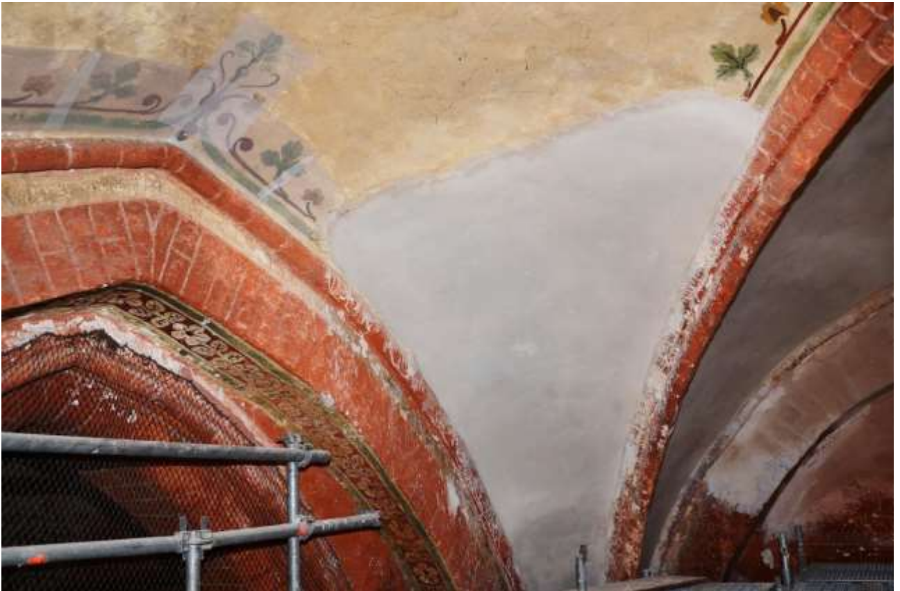
Foto 31 Neuverputzung im Zwickel des Joches S5 (Blick nach Südwest)
