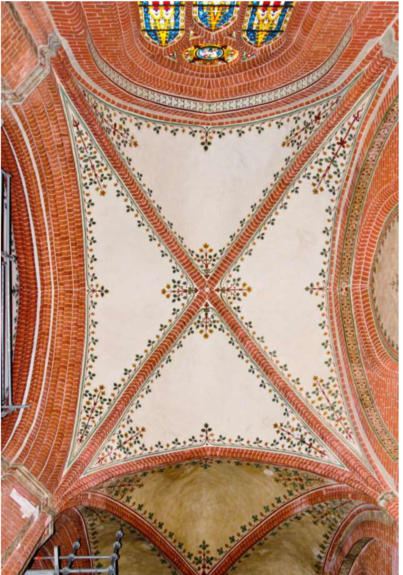
Foto 51 Gewölbe des Joches N1 nach der Restaurierung
