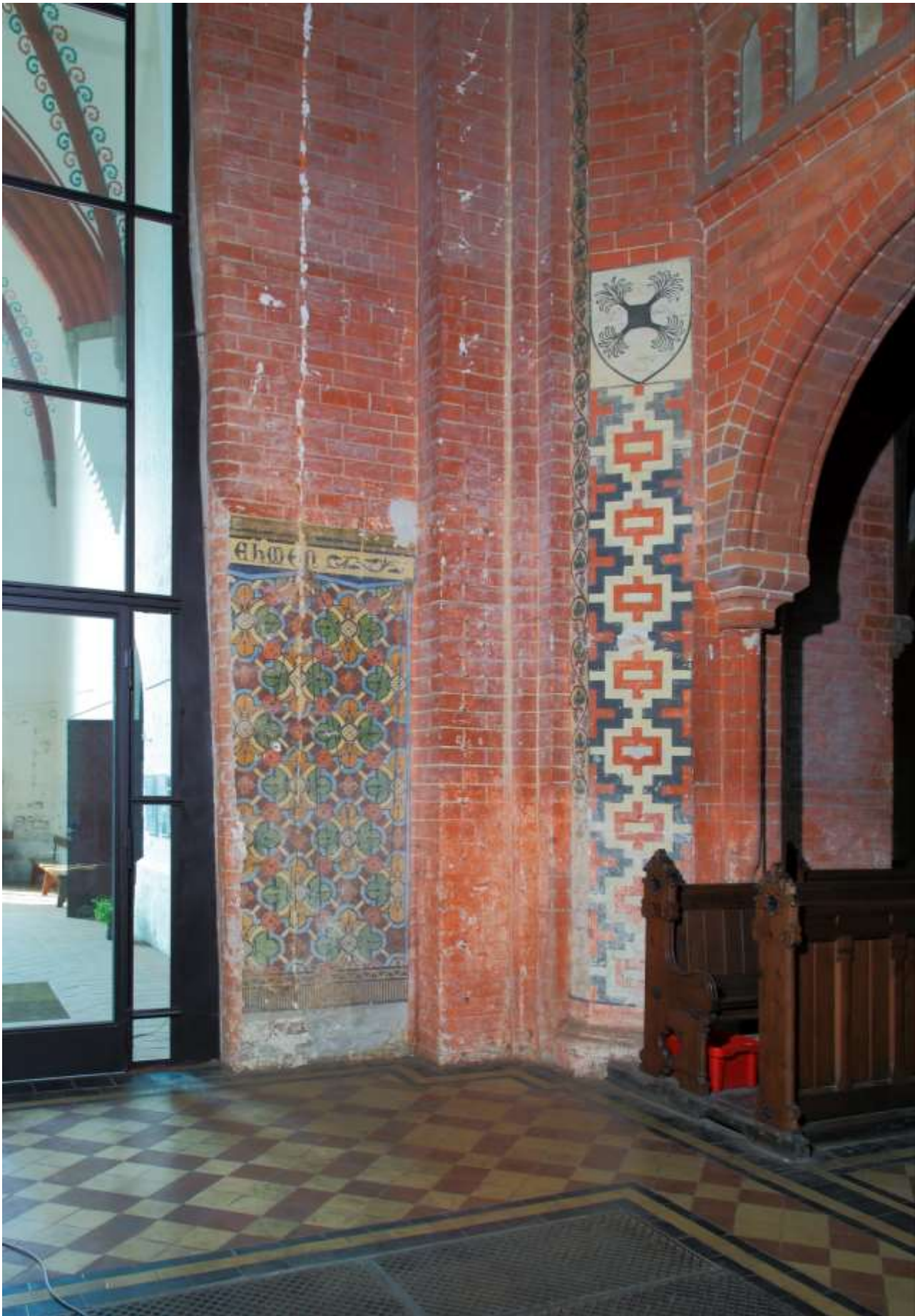
Foto 56 Blick in die Nordwestecke des Joches S5 – vor der Restaurierung
