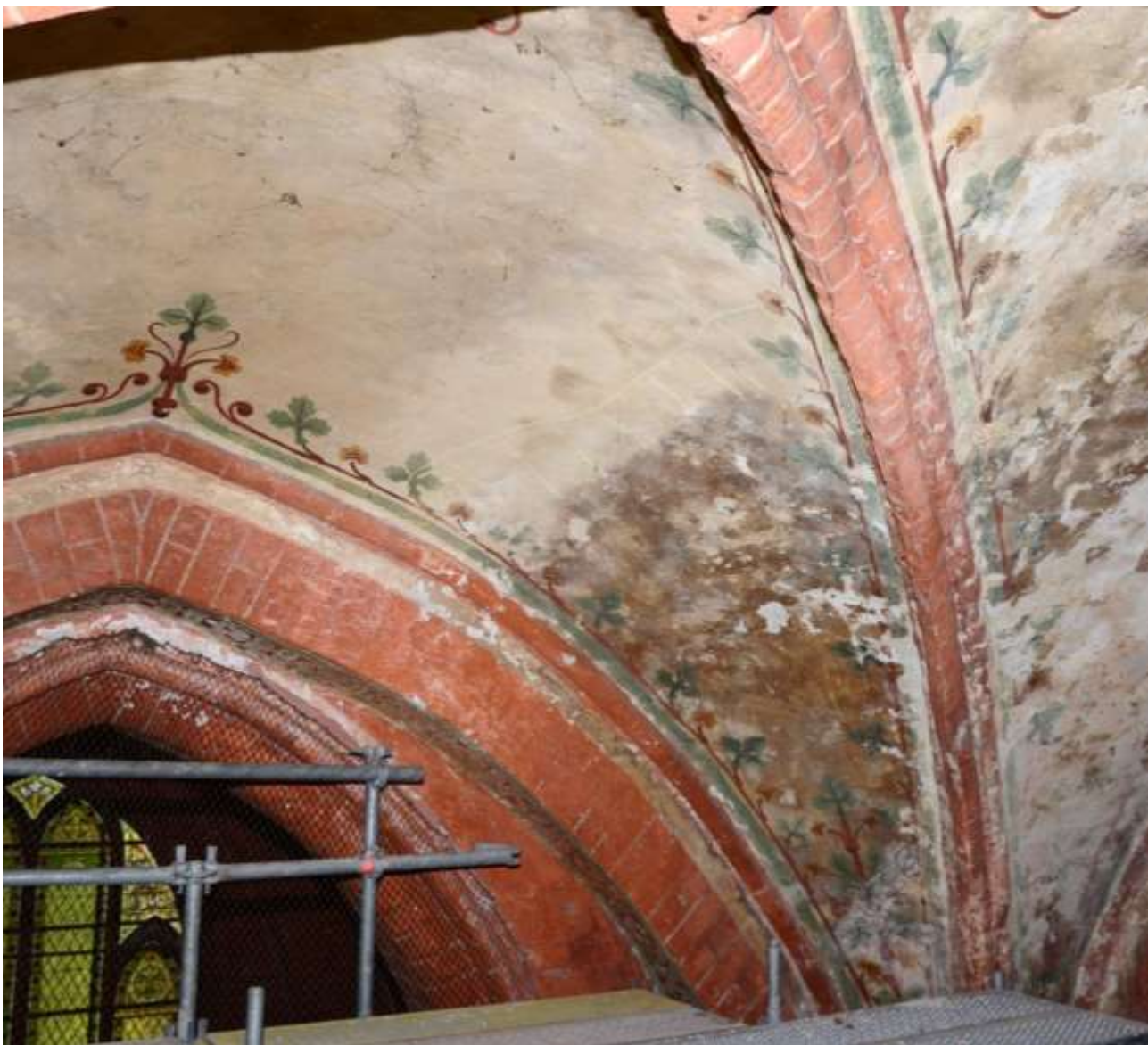
Foto 29 Für die Maurer markierte Bereiche im Gewölbe des Joches S5 (Blick nach Südwest)
