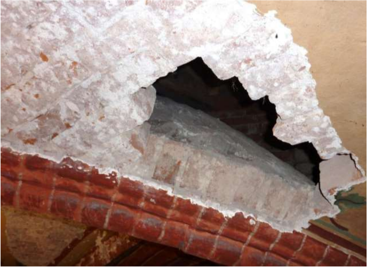
Foto 30 Stark geschädigtes Mauerwerk musste zum Teil ergänzt werden
