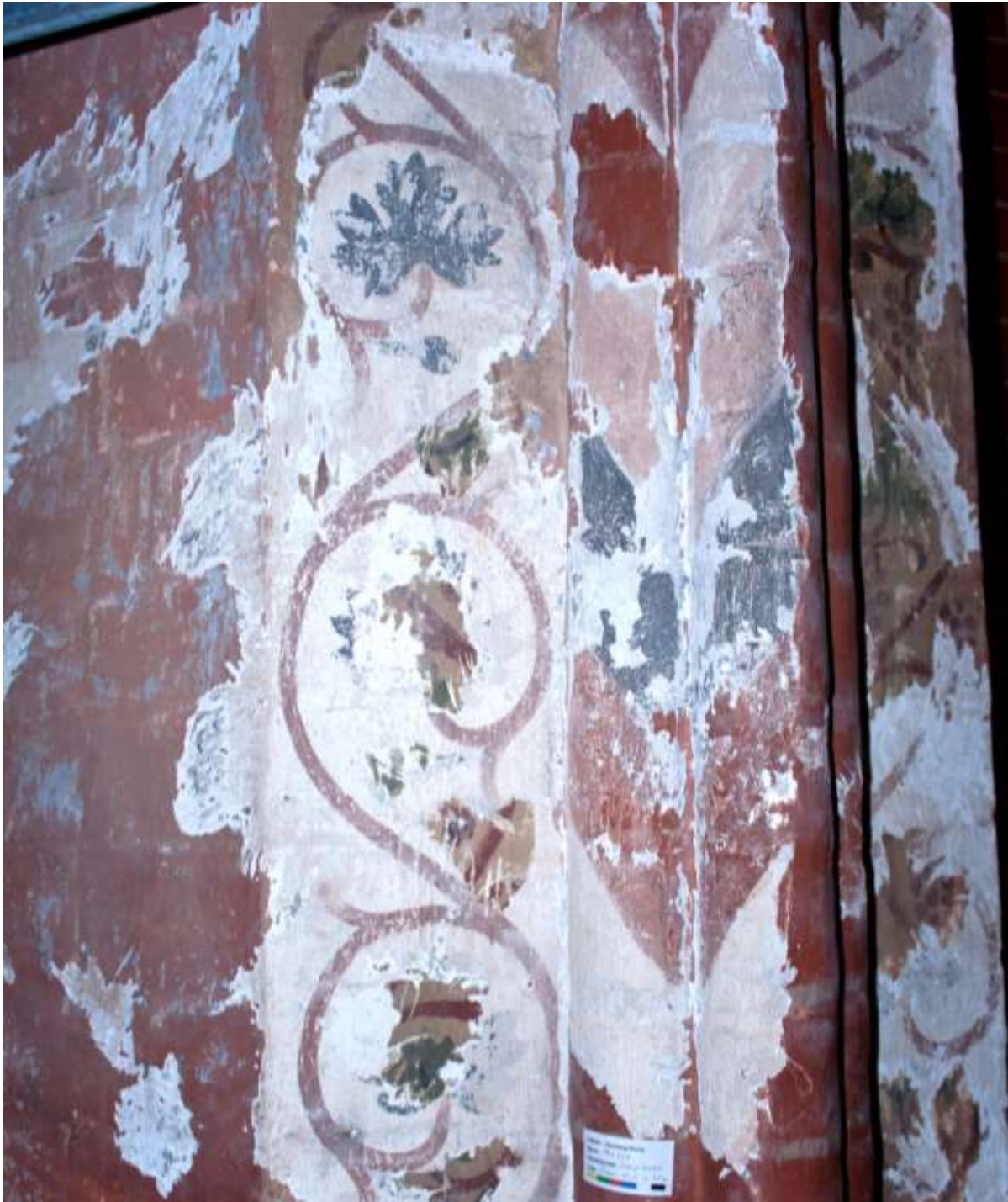
Foto 16 Freilegung der historischen Rippengestaltung auf den Pfeilern
