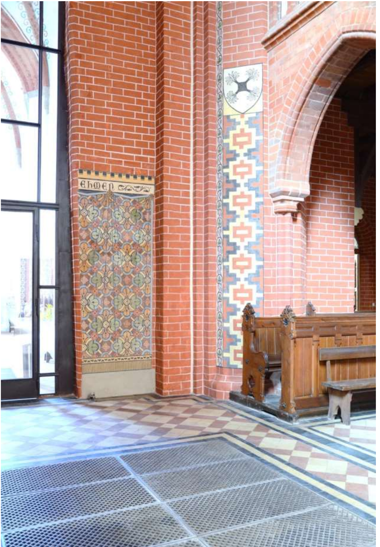
Foto 57 Blick in die Nordwestecke des Joches S5 – nach der Restaurierung
