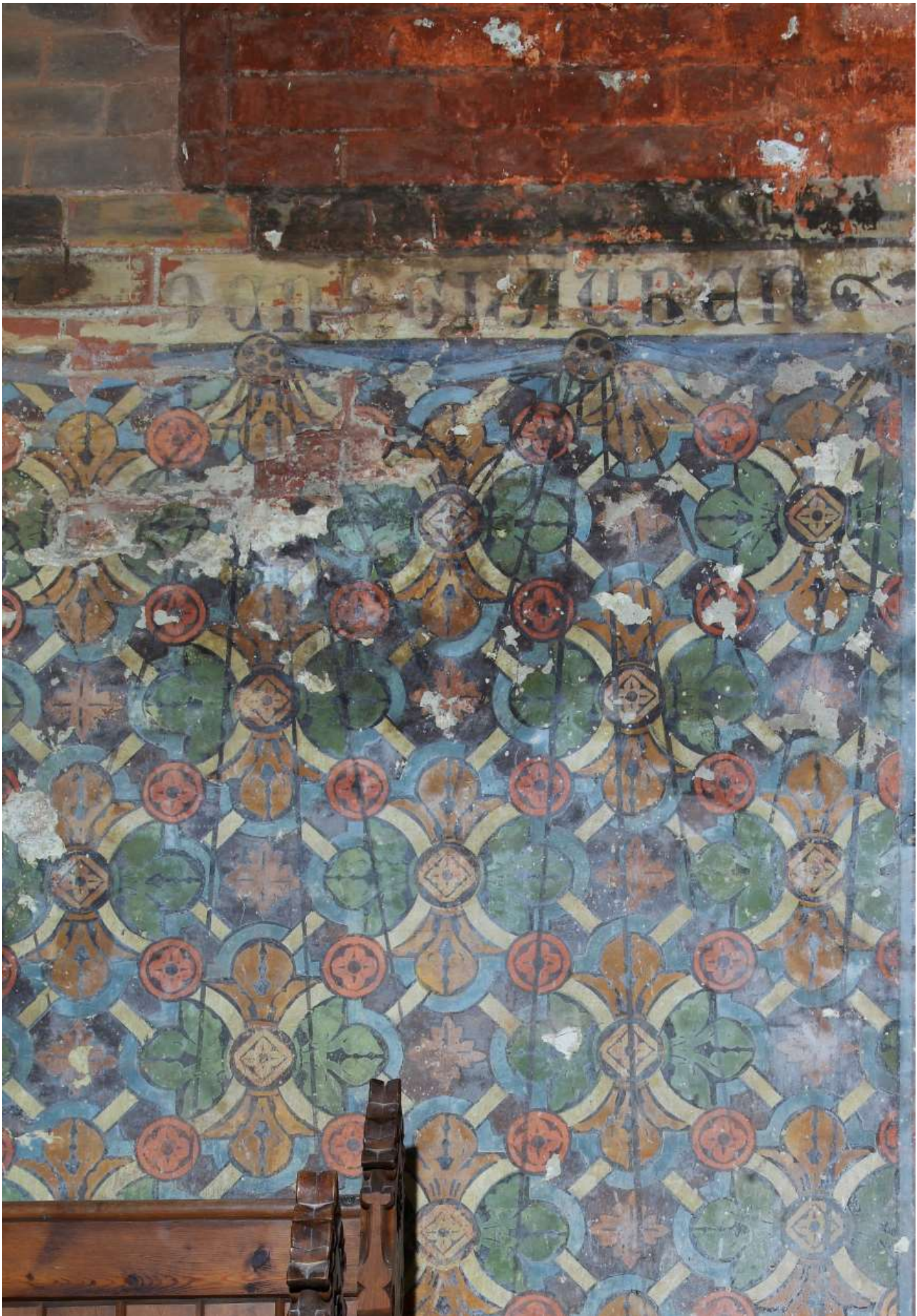
Foto 48 Detail der Nordwand des Joches N2 vor der Restaurierung
