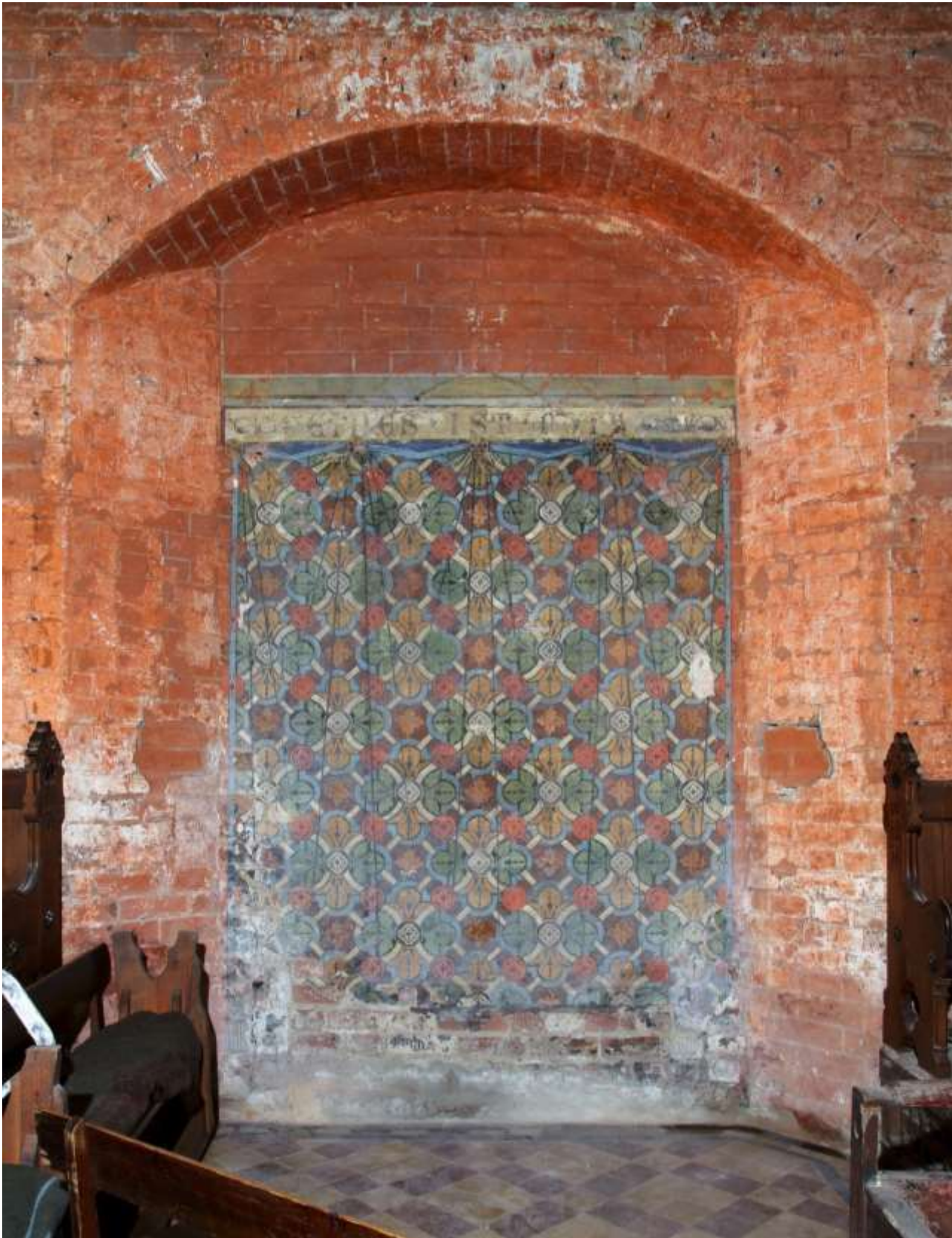
Foto 46 Vorhangmalerei auf der Nordwand des Joches N4 vor der Restaurierung
