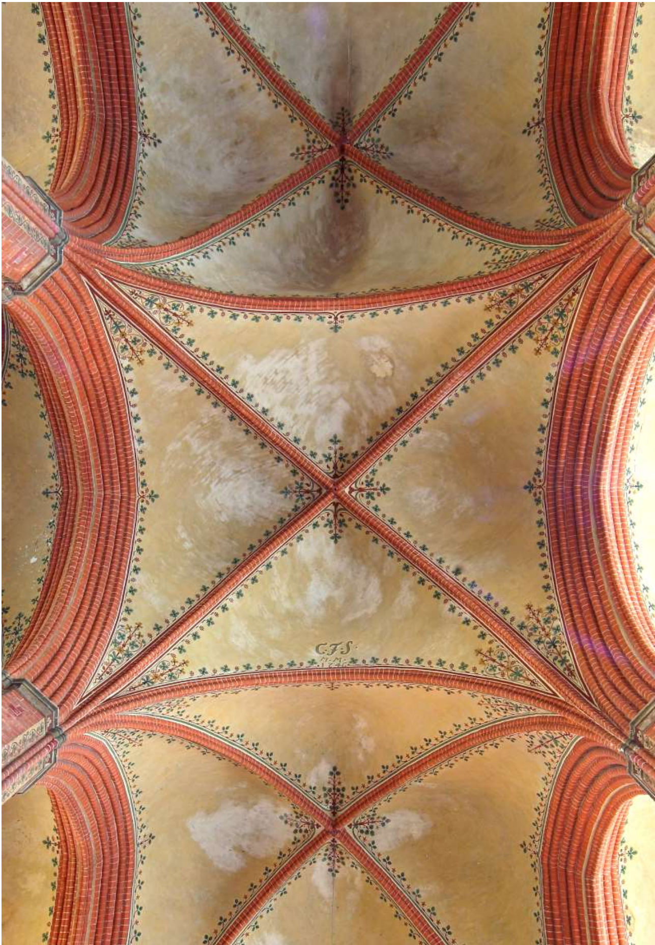
Foto 54 Gewölbe des Mittelschiffes vor der Restaurierung
