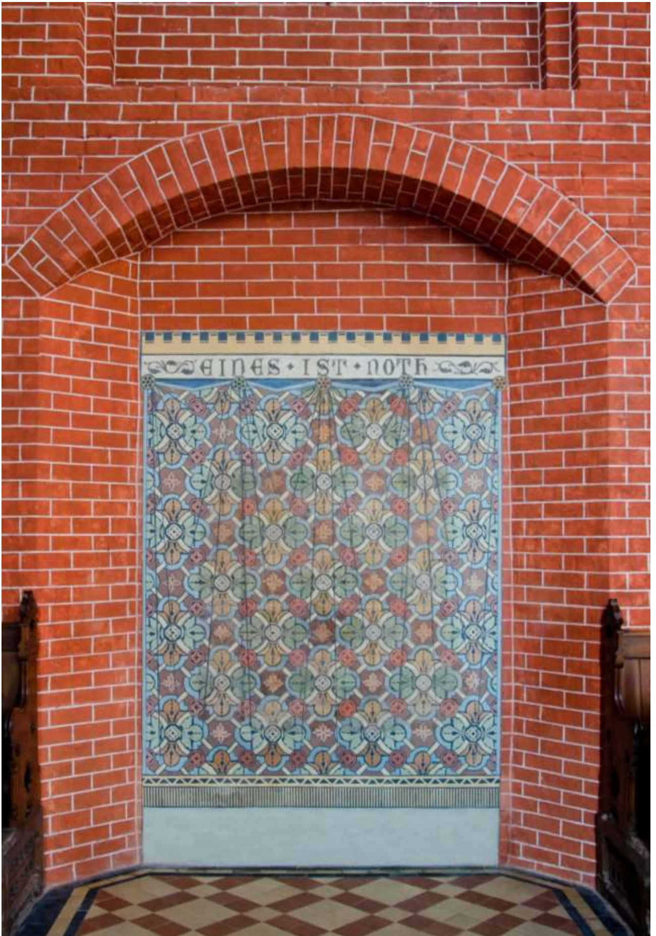
Foto 47 Vorhangmalerei auf der Nordwand des Joches N4 nach der Restaurierung
